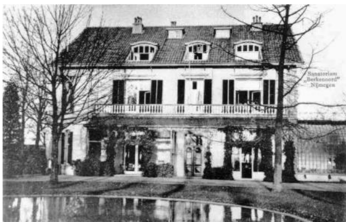
Sanatorium Berkenoord, Graafseweg 296
